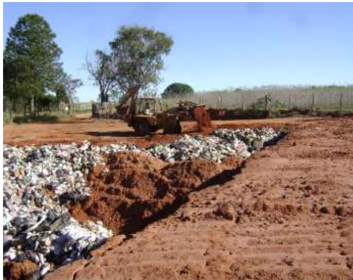
FIGURA 09: Aterro em valas de Echaporã. FONTE: CIVAP, 2013.
